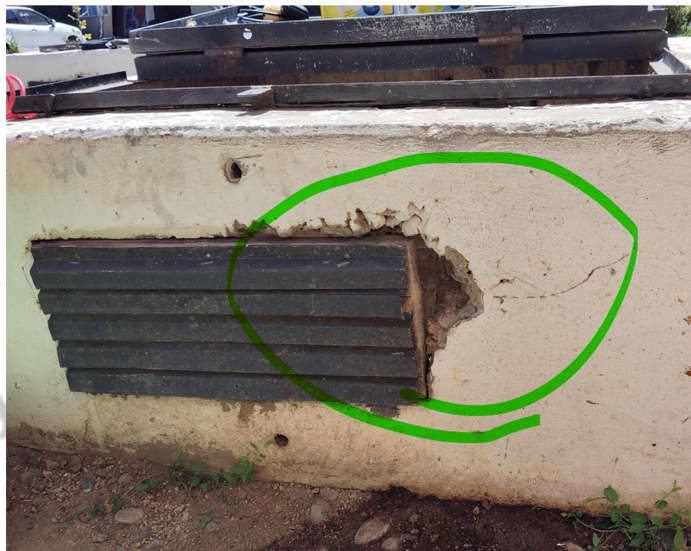
ESCOTILLA SALA DE BOMBAS
