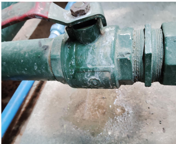
FUGA EN VÁLVULA SUCCIÓN
